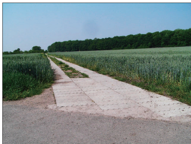
Obr. 4: Napojení, prefabrikáty jsou uloženy v celé šíři
