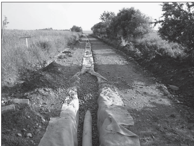
Obrázek 9: Pokládání drenáží do středu vozovky
