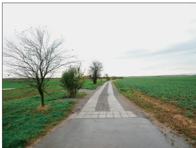
Obr. 10: Napojení na HPC, prefabrikáty jsou uloženy napříč
