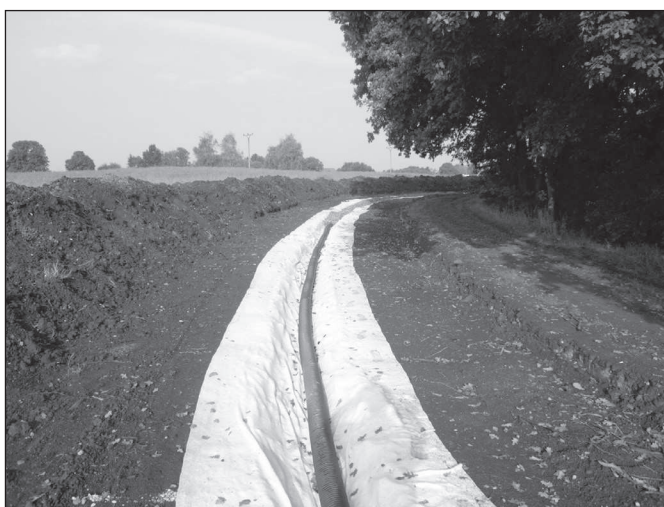
Obrázek 19: Pokládání drenáže do středu
