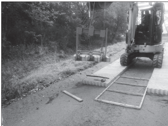
Obrázek 18: Pokládání prefabrikátů po 3 ks
