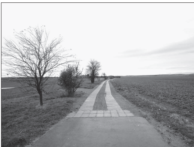
Obrázek 10: Napojení na HPC, prefabrikáty jsou uloženy napříč
