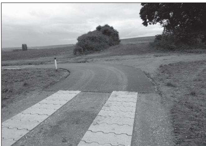
Obrázek 11: Řešení ostré zatáčky pomocí asfaltového betonu
