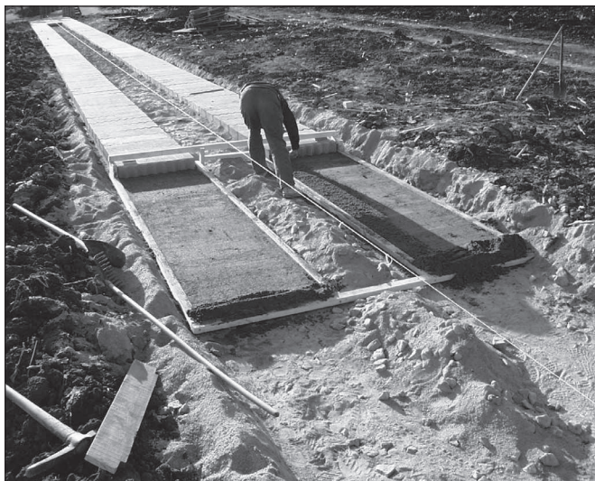
Obrázek 3: Pokládání do podkladního betonu
