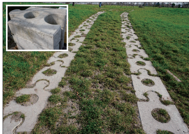
Polní cesta ve Dvorech u Nymburka Prefabrikát pro zpevnění polních cest
