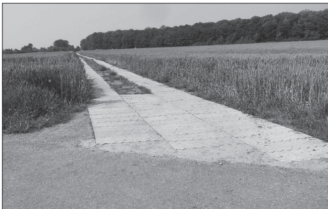
Obrázek 4: Napojení, prefabrikáty jsou uloženy v celé šíři
